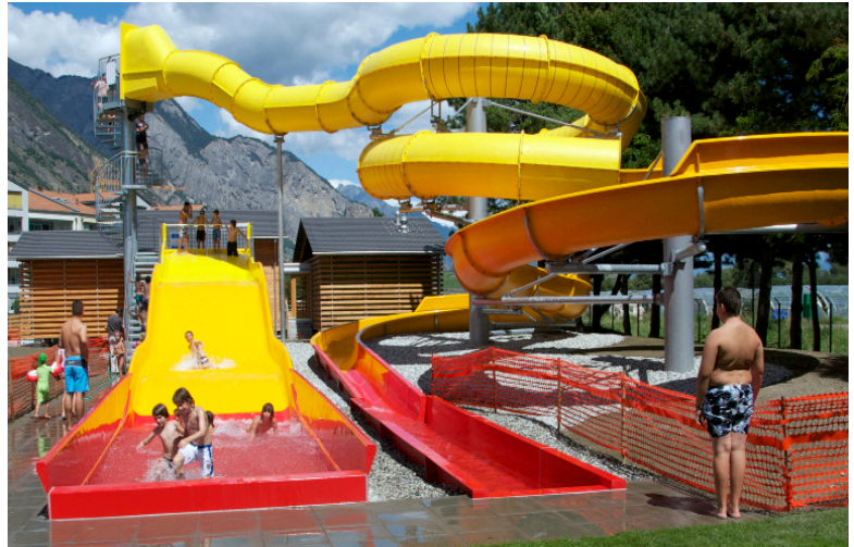
Die in Zusammenarbeit mit der Thallessa GmbH erstellte Anlage durfte dem Kunden im Juli 2010 schlüsselfertig übergeben werden.
